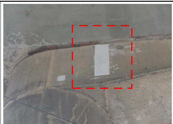
균열(Cw=0.3mm) 보수 (P25)
