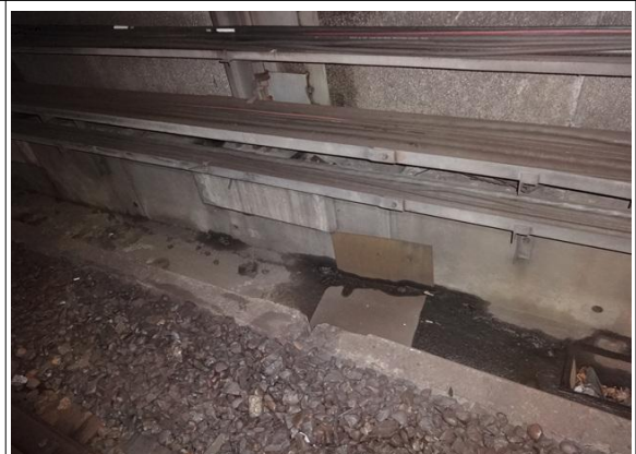
신축이음 상부 전경 (P30 외선)
