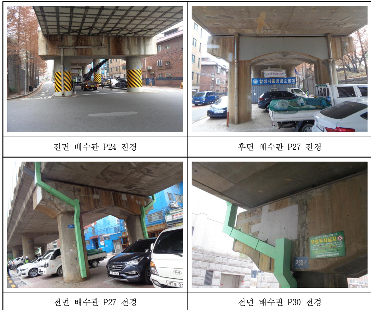
【그림 II-7.3.14】 배수시설 현황
