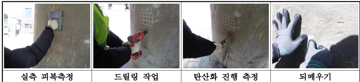
【그림 II-7.3.21】 탄산화 깊이 측정 절차
